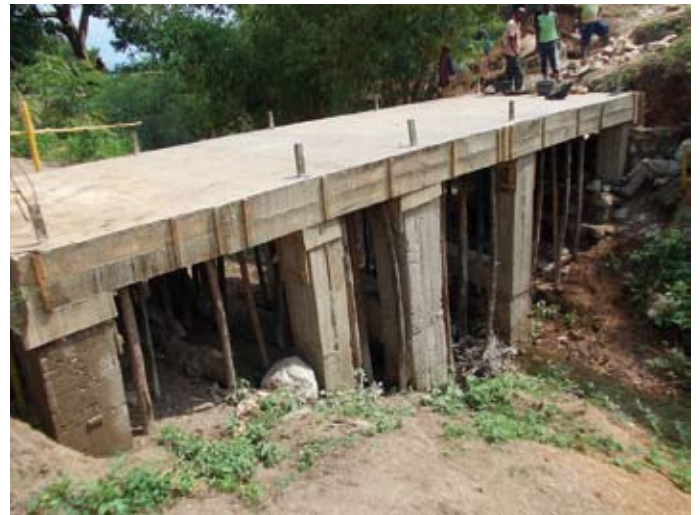
Construction d'un pont à Kabindula
